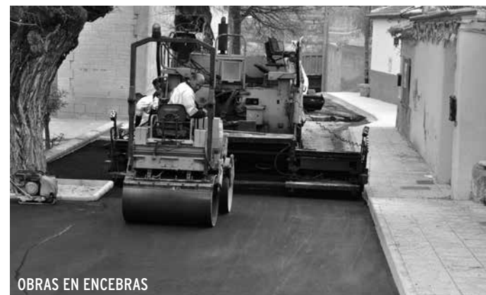
OBRAS EN ENCEBRAS
