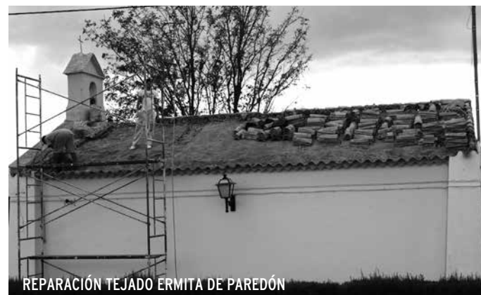
REPARACIÓN TEJADO ERMITA DE PAREDÓN
